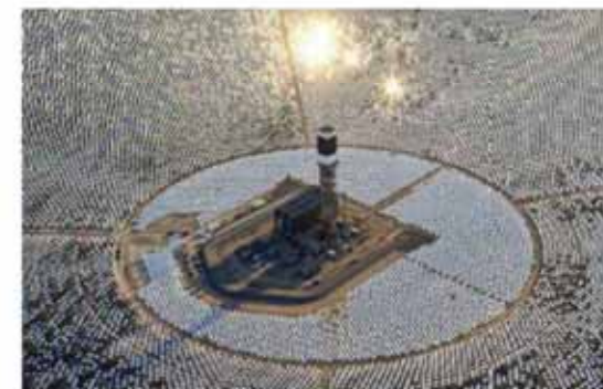
Ryc. 14. Fragment elektrowni słonecznej w Ivanpah w Kalifornii (USA).
