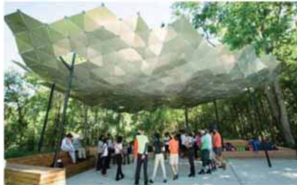
Ryc. 63. Altana zbudowana ze starych znaków
