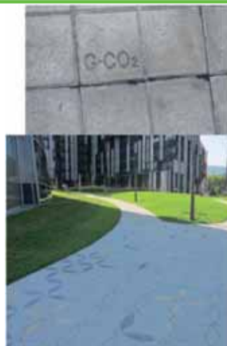
Ryc. 55. Płyta zawierająca Geosilix pochłaniający CO 2 z atmosfery
